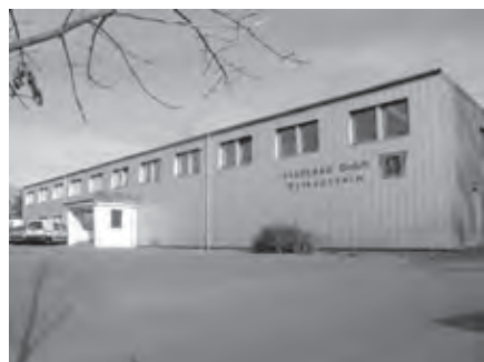
Sanierte Fassade der Stahlbau GmbH
